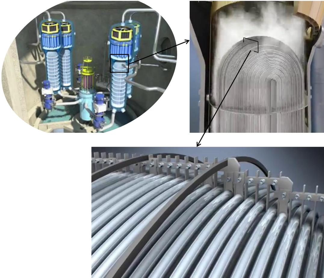
Figure 54 – Les tubes de générateurs de vapeur dans une centrale REP (images Framatome)
