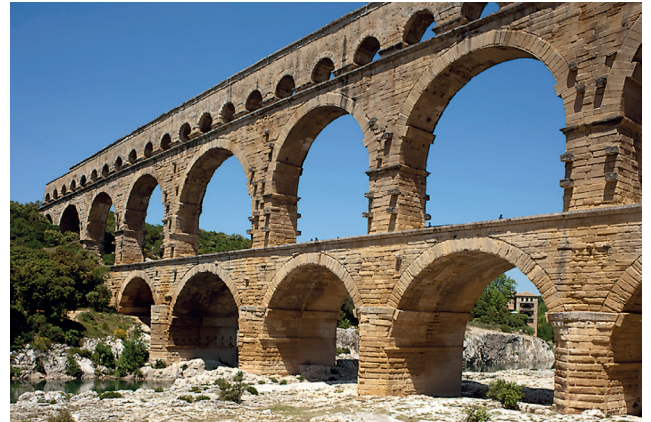
Fig. 1. Pont du Gard, aqueduc romain du I er siècle, dont la structure est composée d'arcs en plein cintre.
