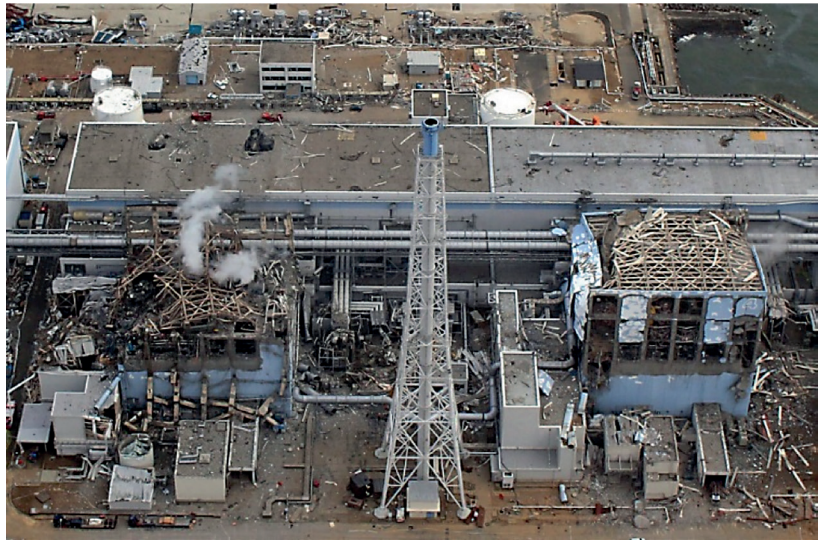
Fig. 8. Centrale nucléaire de Fukushima.
