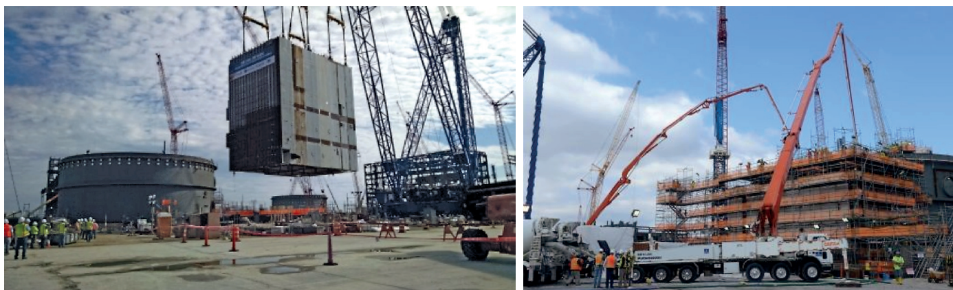
Fig. 236. Transfert de module (photo de gauche) et bétonnage sur site (photo de droite) d'un module de l'AP1000 ( https://www.world-nuclear-news.org/Articles/Largest-module-in-place-at-second-Vogtle-AP1000 ).
