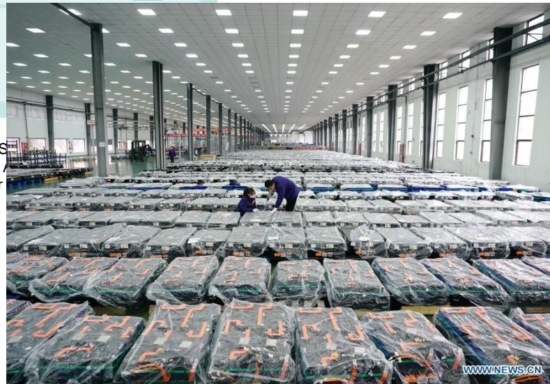
Entrepôt de stockage de batteries (neuve) à Tangshan, province de Hebei (Chine) en 2020 http://www.xinhuanet.com/english/2020-11/29/c_139551144_3.htm
