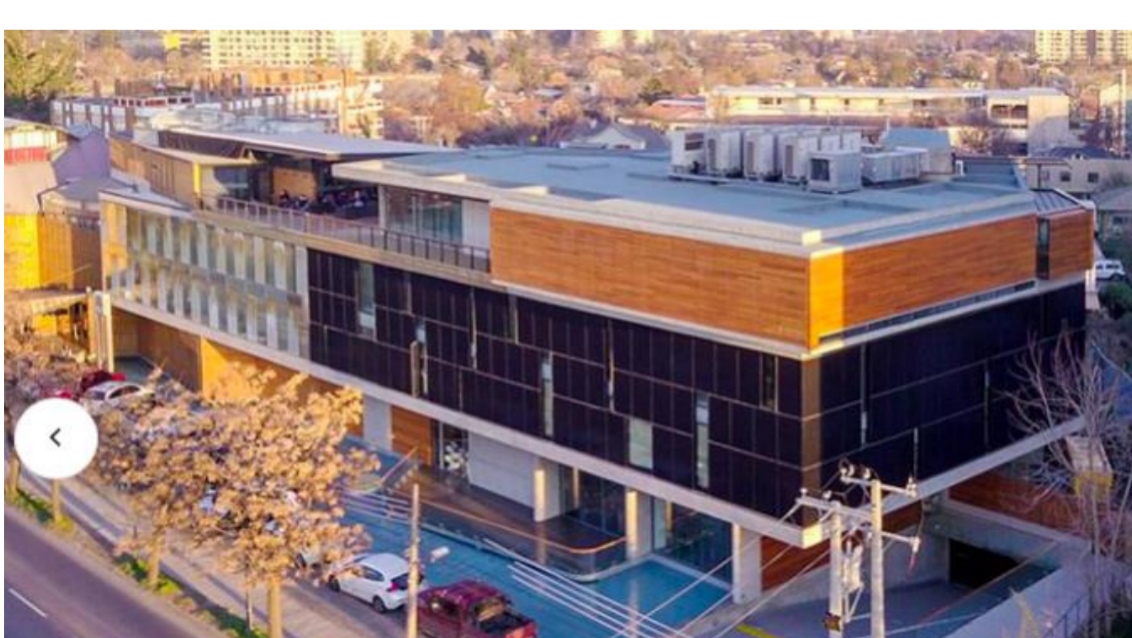
Facade Instituto Nacional de Ortodoncia (Chile) Source: https://nuevacordova.cl/sustentabilidad.htm
