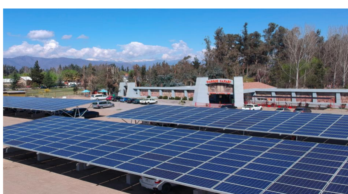
Carport Parque Safari Rancagua (Chile) Source: https://risingsunchile.cl/proyectos/
