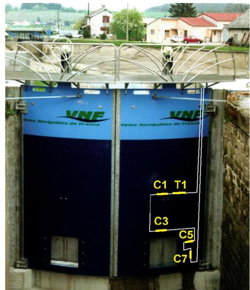
**Figure 8.** Porte d'écluse équipée de capteurs à Réseaux de Bragg
