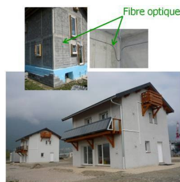
Figure 21 Illustration du déploiement de câbles optiques sensibles sur et dans les murs d'une maison (projet BATIMETRE)
