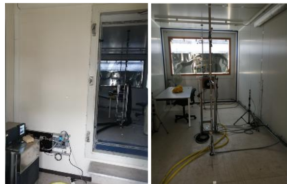
Fig. 4 : Système de chauffage/refroidissement, à gauche: Génération – Bain thermostatique, à droite: Vue de l'intérieur de la cellule Passys
