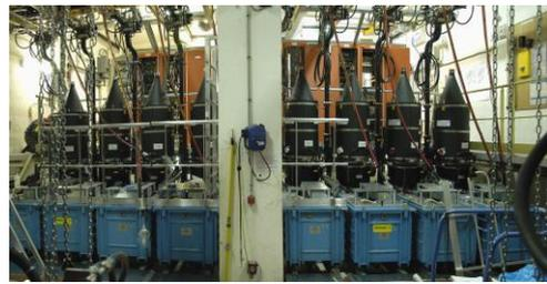
Figure 8 : Ensemble des Klystrons et de leurs interrupteurs associés
