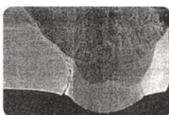
Fissuration dans une ZAT (zone affectée thermiquement) d'une soudure de la boucle de recirculation
