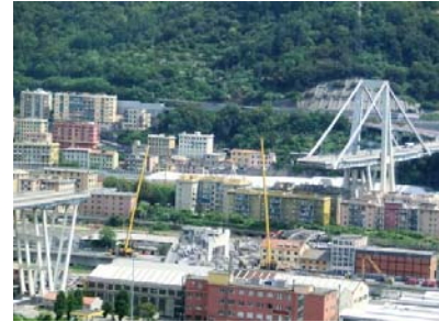
Viaduc de Polcevera, Genova, 2018 (09-1967)
