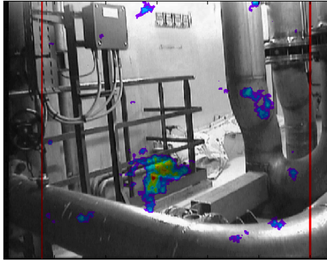
Figure 8.1 – Image caméra gamma de la scène sur 2 \times 30 s : on peut discerner un signal gamma au niveau de la partie de la tuyauterie non blindée.
