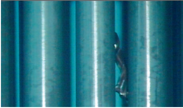
Fig. 20. Corps migrant bloqué entre deux rangées de crayons d'un assemblage REP.
