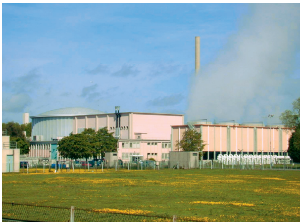
Fig. 61. Vue d'ensemble du réacteur OSIRIS.
