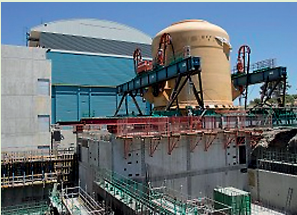
Fig. 8. Le chantier du RES, avec la mise en place de l'enceinte de confinement métallique.
