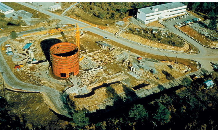
Fig. 47. Construction du réacteur MASURCA.
