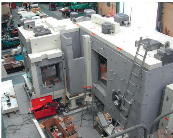
Fig. 84. Construction des cellules blindées du dispositif expérimental VERDON, au sous-sol du laboratoire STAR.
