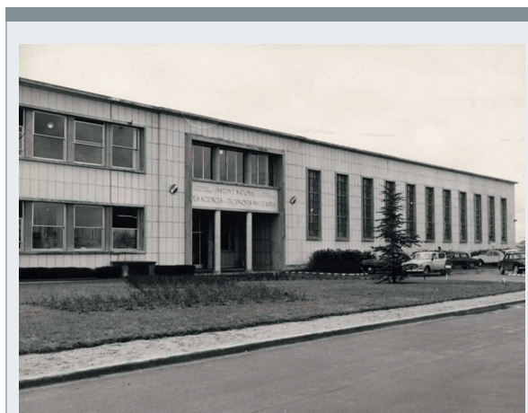
L'INSTN créé en 1956 : le bâtiment d'origine. Un réacteur dédié à l'enseignement, ULYSSE, y a été installé. Il a assuré pendant de nombreuses années (1961-2007) la formation des futurs techniciens et ingénieurs nucléaires.
