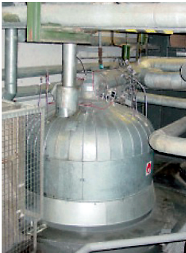
Fig. 124. Piège froid secondaire de PHÉNIX.
