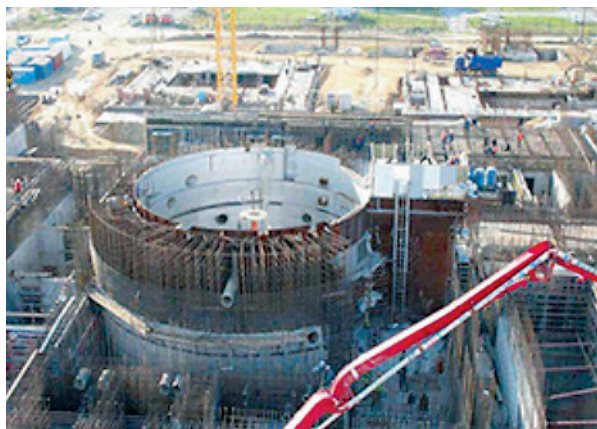
Fig. 55. Construction du réacteur russe BN 800 (juillet 2006).
