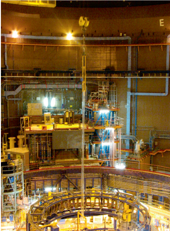
Fig. 82. Dispositif spécial d'évacuation des protections neutroniques latérales.
