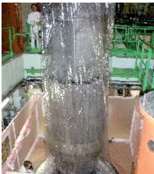
Fig. 100. Manutention d'un échangeur en puits de lavage / décontamination sur PHÉNIX.
