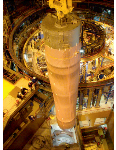
Fig. 85. Sortie d'une pompe primaire sur SPX 1, après nettoyage par carbonatation.
