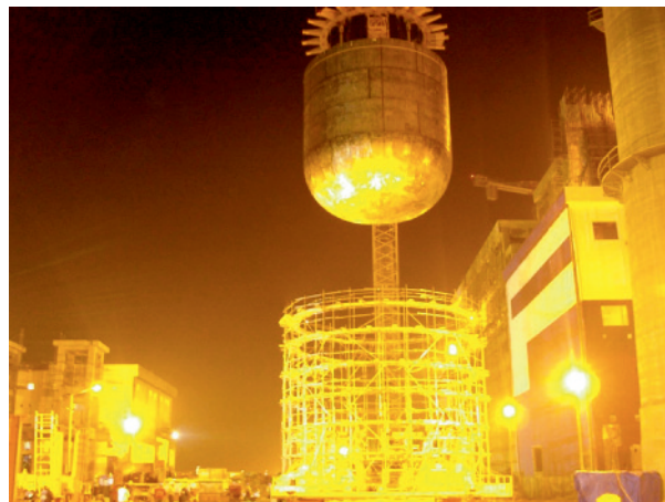
Fig. 6 La construction de PFBR (réacteur rapide sodium), en Inde.
