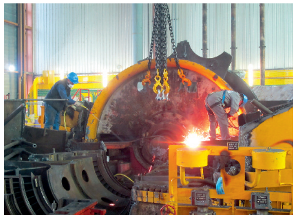
Fig. 90. Démantèlement de l'installation de production d'électricité de PHÉNIX à Marcoule.
