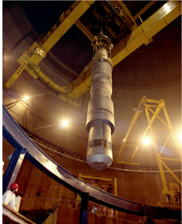
Fig. 113. Un échangeur intermédiaire sur SUPERPHÉNIX.
