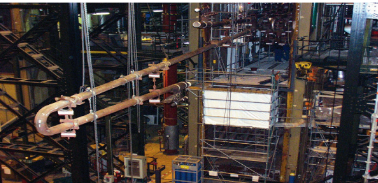
Fig. 67. PHÉNIX : extraction d'un module GV pour réparation après une réaction sodium-eau.
