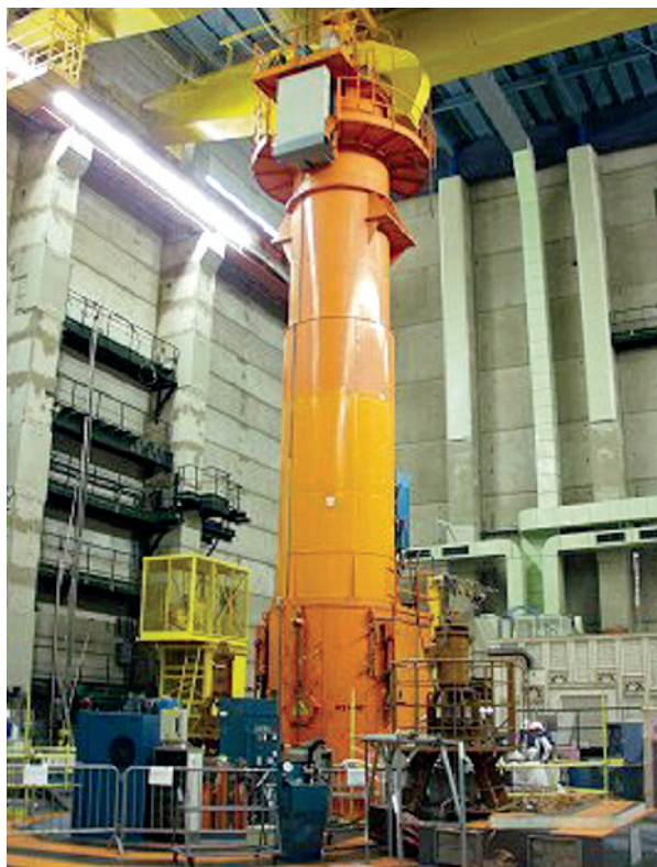
Fig. 68. Hotte de transfert des gros composants primaires de PHÉNIX, en position pour extraction hors du réacteur.
