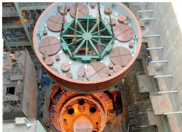
Fig. 56. Introduction de la dalle dans le bloc réacteur du PFBR, à Kalpakkam (Inde).
