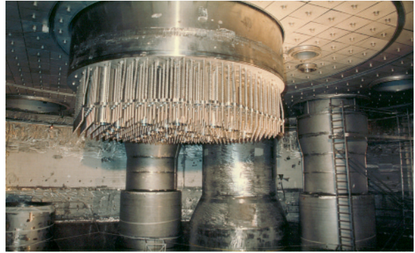
Fig. 88. Vue des structures internes de SUPERPHÉNIX, lors de la construction du réacteur.
