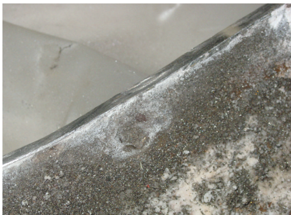
Fig. 96. Trace de « wastage » sur la paroi interne de la virole du générateur de vapeur de PHÉNIX, après la cinquième réaction sodium-eau.
