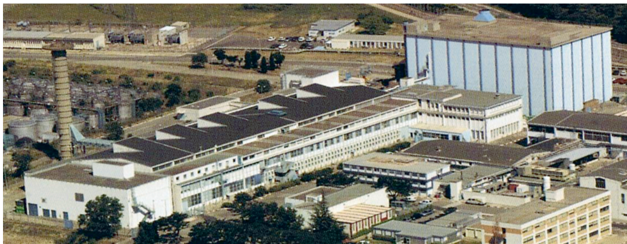
Fig. 173. Vue de l'atelier pilote de Marcoule rénové.
