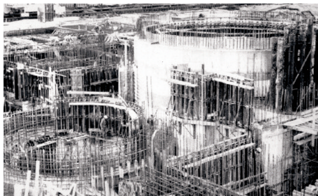
Fig. 3. Le chantier de PHÉNIX, en 1970.
