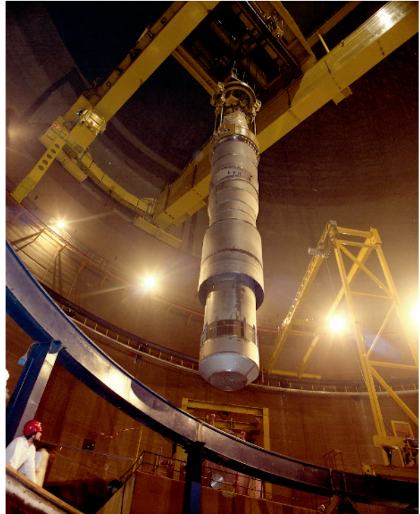
Fig. 113. Un échangeur intermédiaire sur SUPERPHÉNIX.
