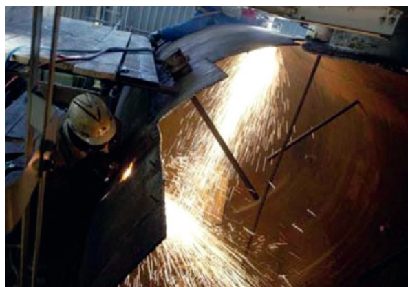
Fig. 76. Découpage final d'un réservoir sodium sur PFR, après son traitement par WVN process.
