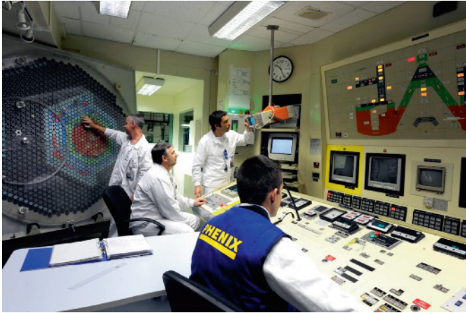
Fig. 35. La salle de commande de la maintenance sur le réacteur PHÉNIX.
