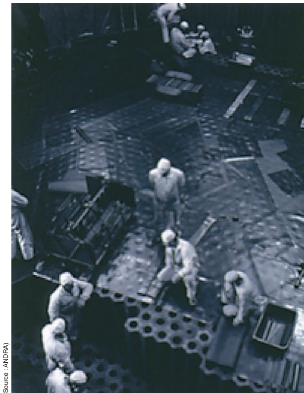
Fig. 54. Vue de l'empilement de blocs graphite dans le réacteur UNGG de Chinon
