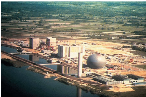
Fig. 9. La centrale UNGG de Chinon.
